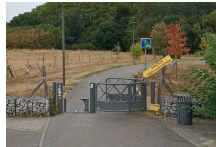
Ce type de dispositif empêche le passage des vélos cargo ou vélos adaptés.
