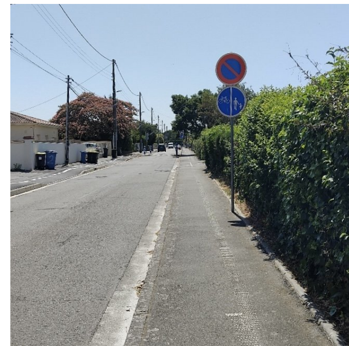
Un trottoir partagé entre piétons et cyclistes est un aménagement à proscrire.
