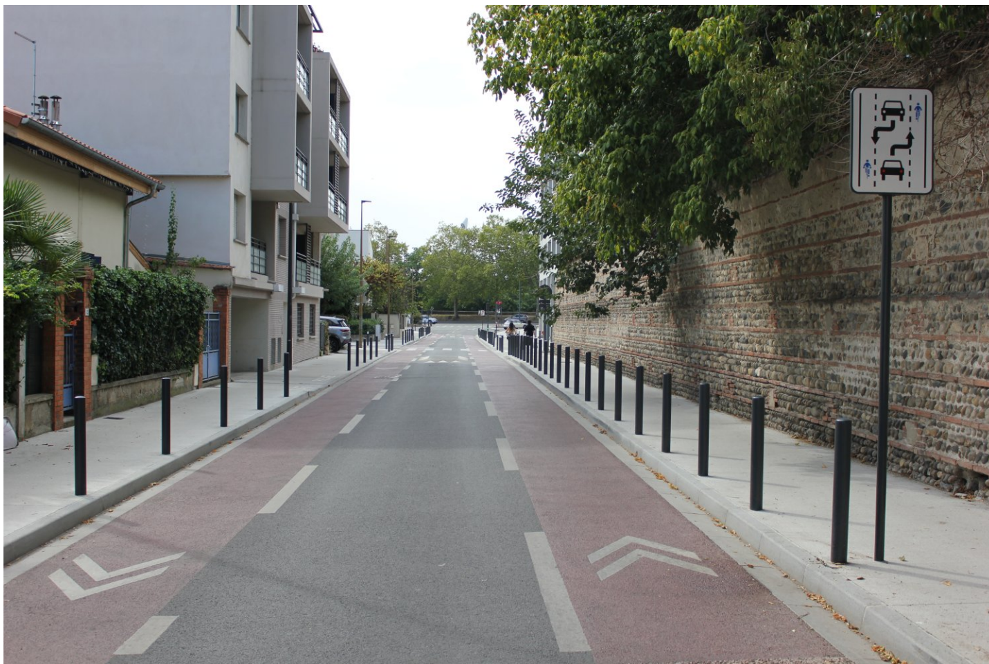
Photographie d'une Chaussée à Voie Centrale Banalisée.
