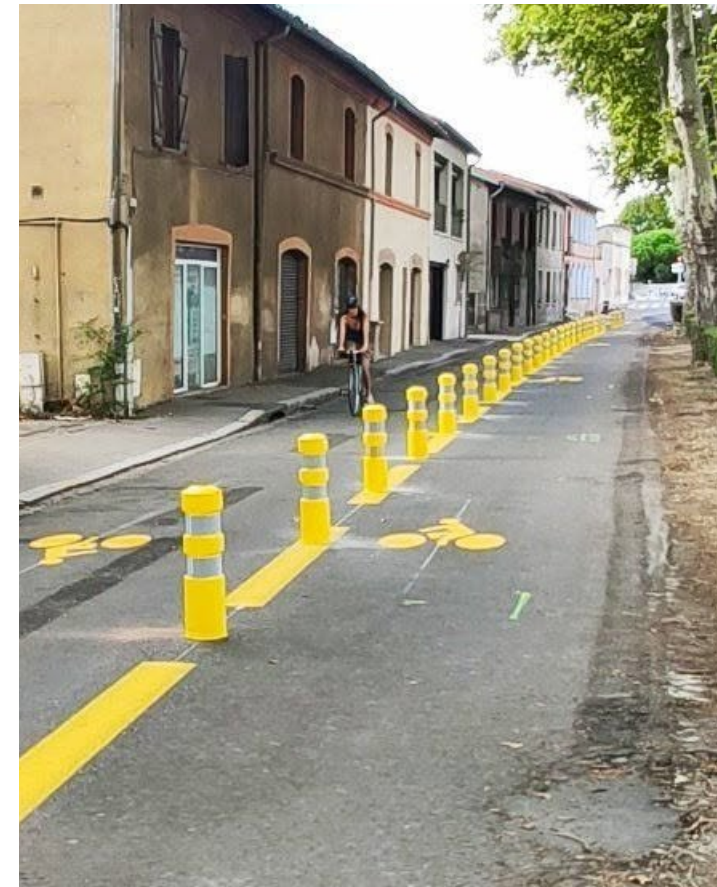
Les aménagements temporaires peuvent permettre de tester des solutions avant des aménagements définitifs.
